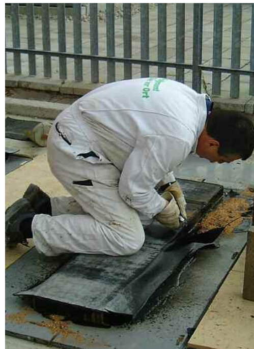
(d) Trimming membrane with a knife
